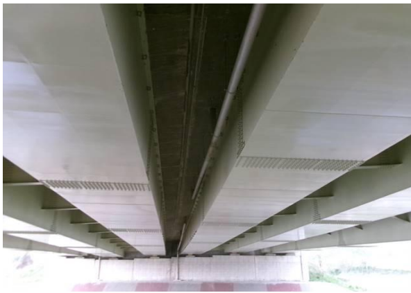
바닥판 하면 및 거더 전경
