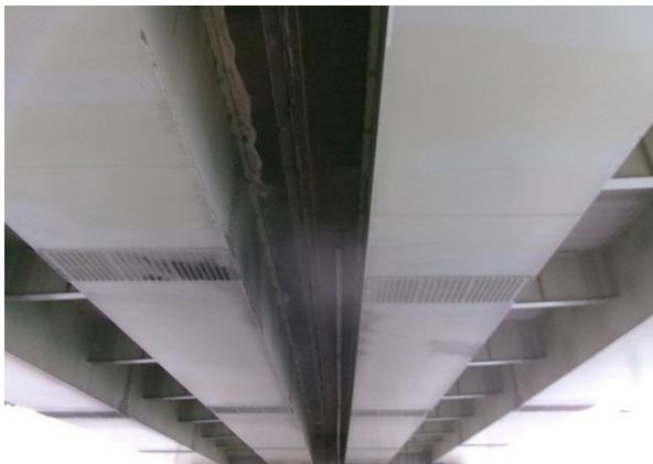
바닥판 하면 및 거더 전경
