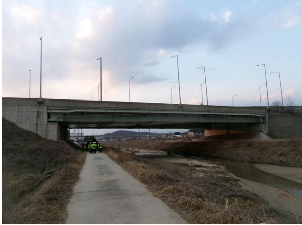
교량 측면 전경
