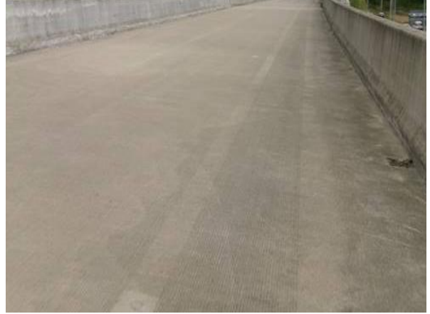
교량 상부 전경
