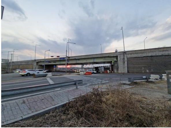
교량 측면 전경
