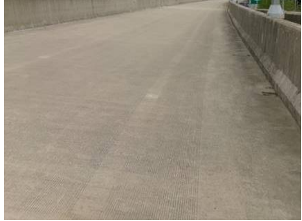
교량 상부 전경
